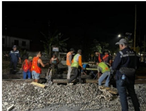
Gambar 2. 21 Pengawasan Perbaikan Geometri Jalan Rel
