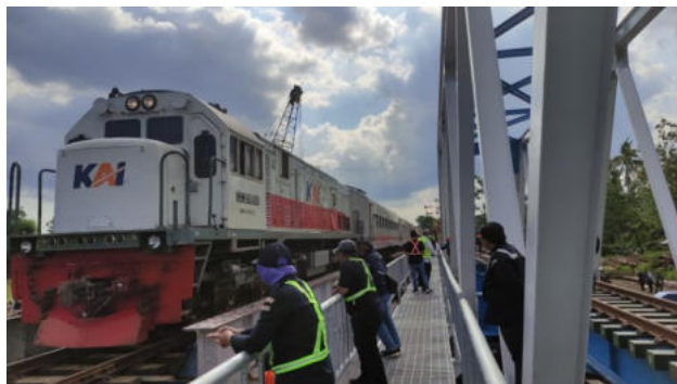
Gambar 2. 4 Pelaksanaan Pergeseran Jembatan WTT 51,6 BH 307
