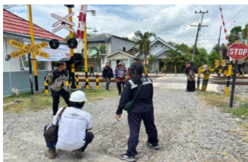
Gambar 2. 22 Koordinasi dan persiapan pelebaran akses jalan
