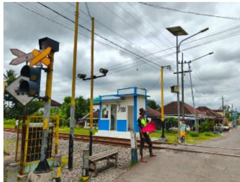
Gambar 2. 23 Monitoring Pekerjaan Pemeliharaan EWS
