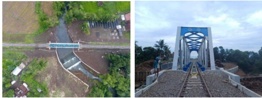
Gambar 2. 25 Peningkatan 2 Unit Jembatan KA BH 613
